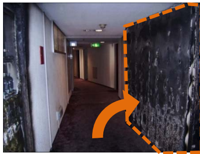
防火戸を開けた状態 ※点線部=防火戸
