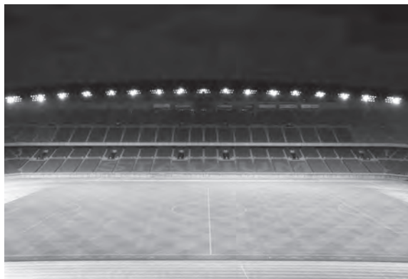
競技用照明のLED化でピッチは明るくなった
