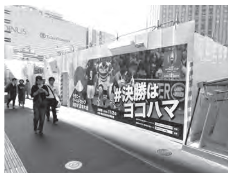
横浜駅中央西口駅前広場整備工事の仮囲い装飾
