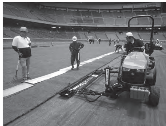
天然芝敷設工事
