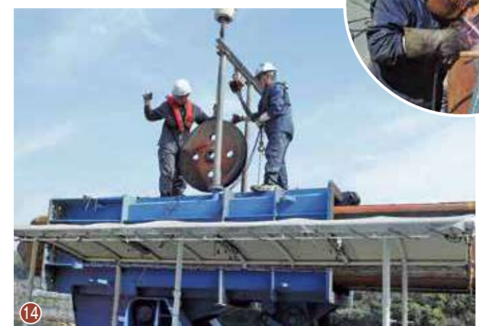
⑪整備が完了した浚渫作業船 ⑫⑬浚渫作業船団の修理の様子
