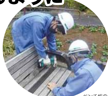
ベンチ板の取替え作業の様子
