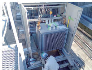
▲機器の更新工事
