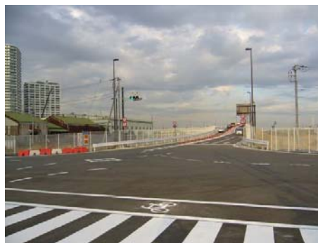
臨港幹線道路(臨港パーク～瑞穂、一部暫定供用)(平成 20(2008)年開通)
