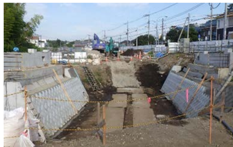
帷子川における河川改修（旭区）
