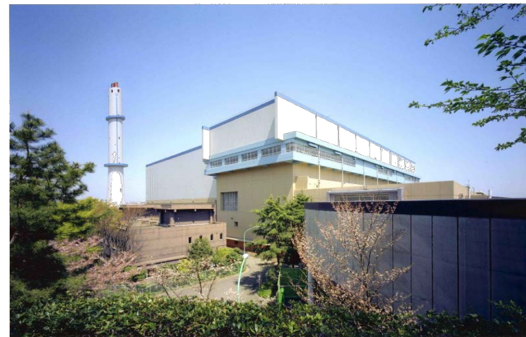
焼却工場（保土ヶ谷工場）
