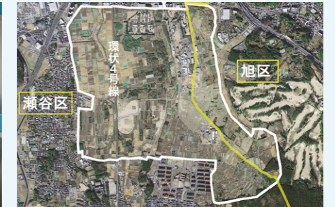
旧上瀬谷通信施設
