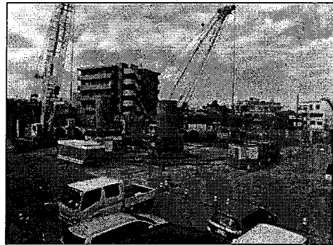
現況写真 (東側から北西方向を撮影)
