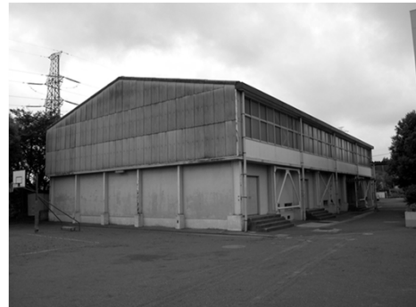
現況写真(体育館)
