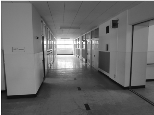
現況写真(廊下)
