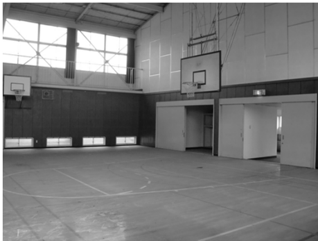
現況写真(体育館)
