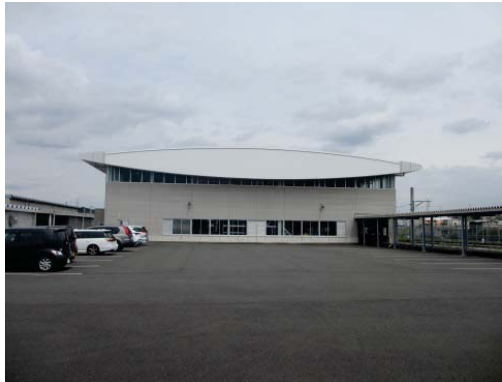
検修庫等施設増築
