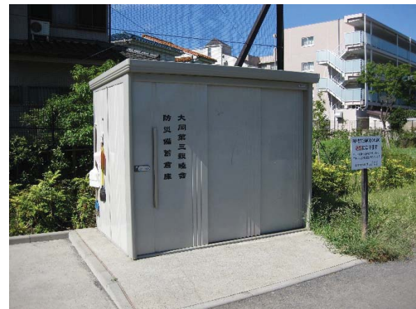
●町内会防災倉庫
