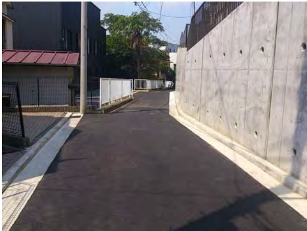
道路整備 拡幅 60m
