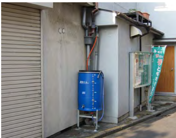
雨水タンク整備
