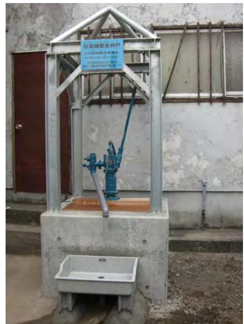
井戸ポンプ整備
