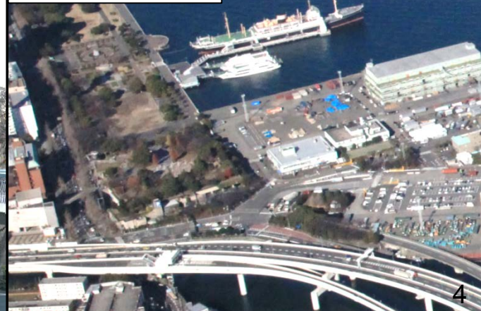
③埠頭基部付近
