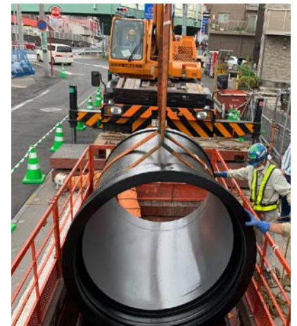
耐震管への更新工事
