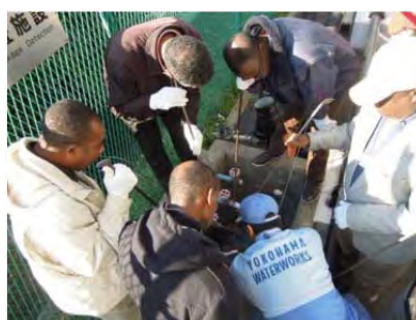
漏水調査実技研修
