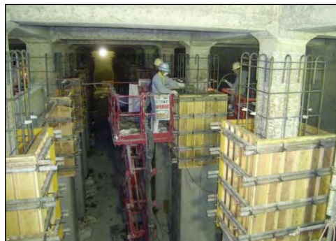
配水池の耐震補強工事
