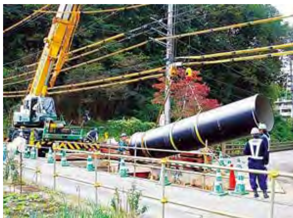
図 地震に強い水道管への取替え工事
