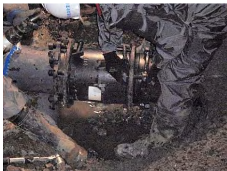
配水管の布設替工事
