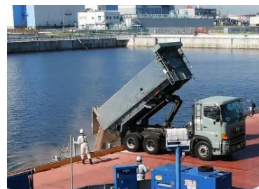
焼却灰を処分場に投入する様子
