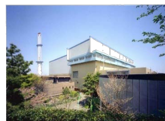
休止中の保土ヶ谷工場
