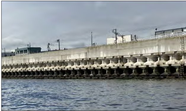
【金沢区福浦地区護岸復旧状況】
