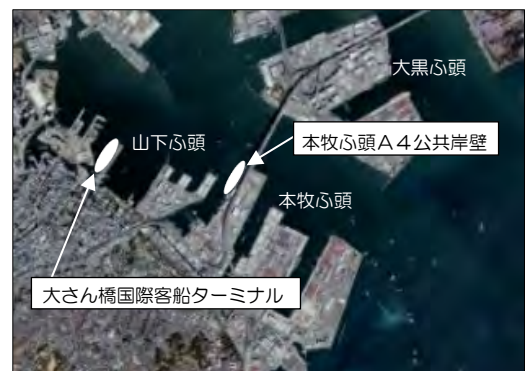
【陸上電力供給設備の整備箇所】
