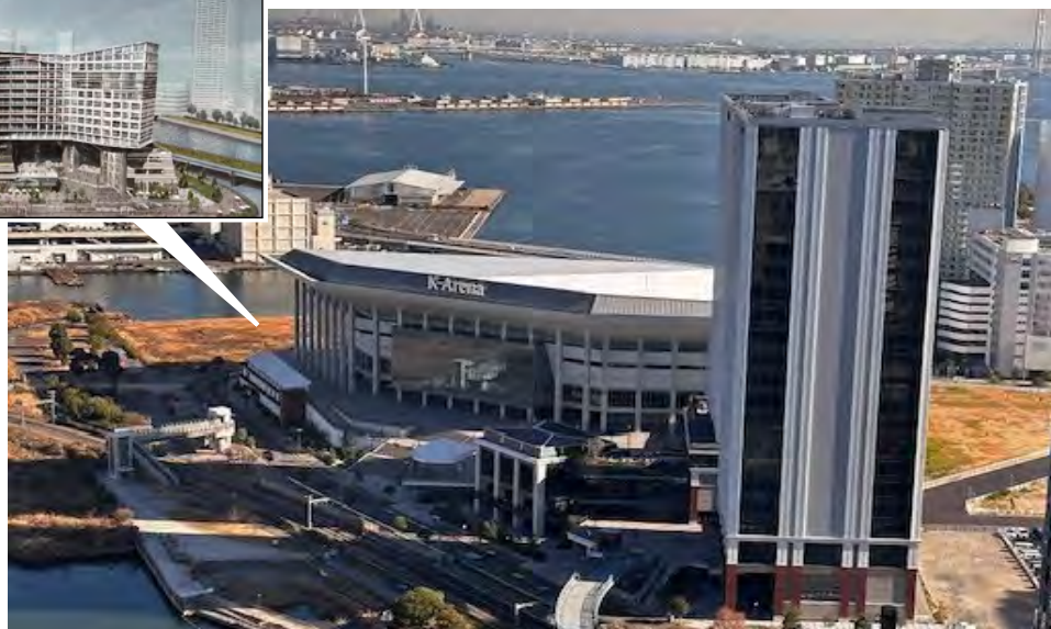
【観光エンターテインメントを軸とした街づくりが進む60・61・62街区周辺】
