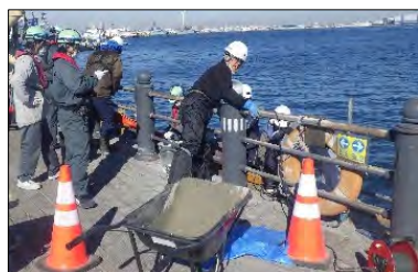
【赤レンガパーク護岸改修】
