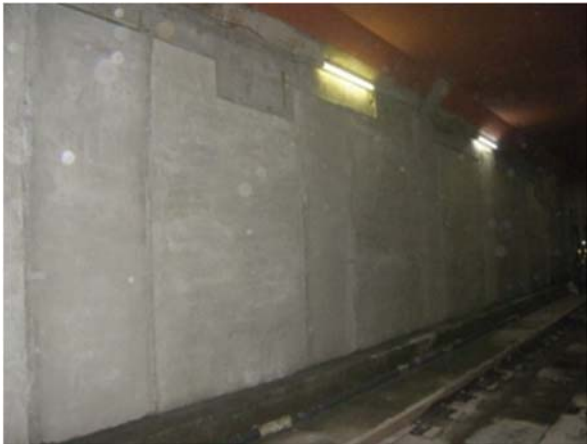
<関内駅構築補修>
