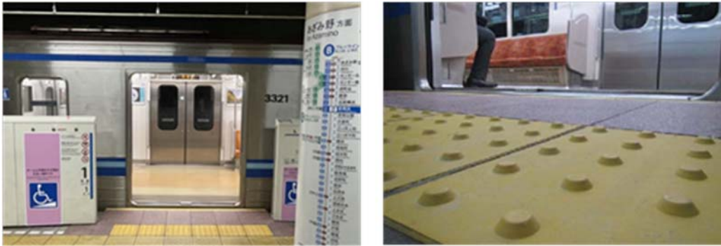
＜新横浜駅 段差・隙間縮小施工箇所＞
