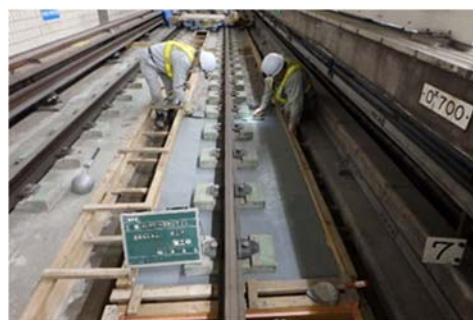
<軌道改良工事>
