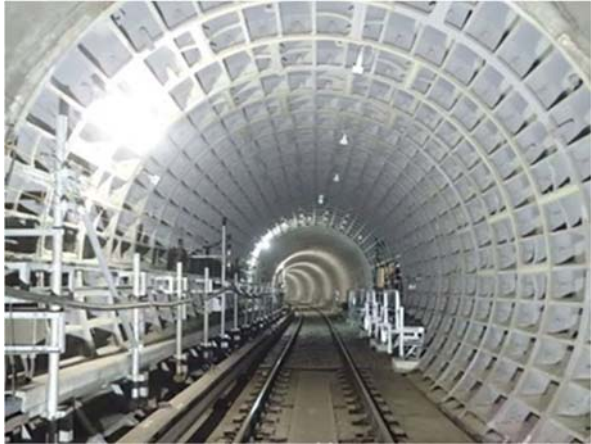
<シールドトンネルの補修>
