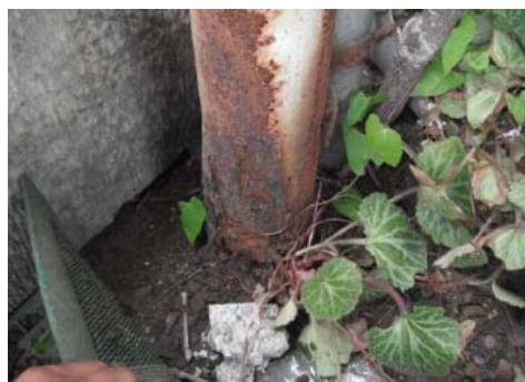
【上屋の支柱部分】
