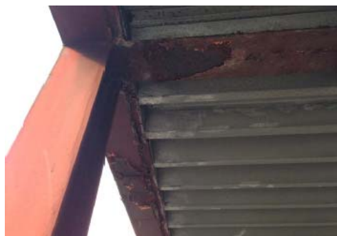
【上屋の梁部分】
