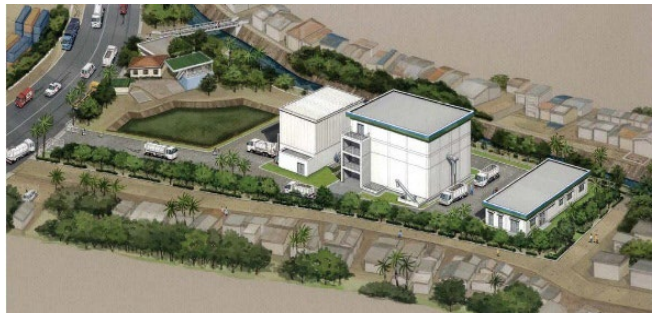
市内企業がフィリピン・セブで温室効果ガス発生抑制に貢献（Y-PORT事業を通じ、市内企業が設計を受注した汚泥処理施設の完成予想図）
