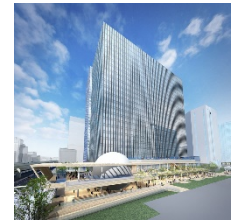
横浜ゲートタワー (三井住友海上 神奈川静岡本部 いすゞ自動車株式会社 本社 進出予定)
