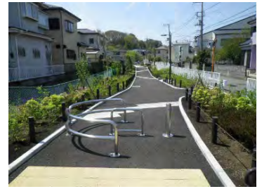
旧河川(帷子川)を活用したグリーンインフラ
