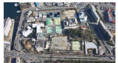
中部水再生センター航空写真
