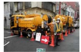
下水道管清掃状況
