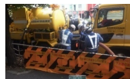
下水道管清掃状況
