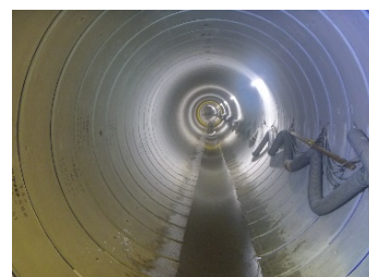
雨水幹線整備状況(推進工法)
