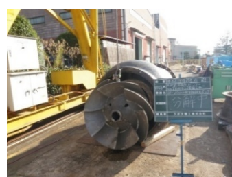
ポンプの再整備（長寿命化）
