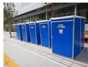
災害用ハマッコトイレ設置状況
