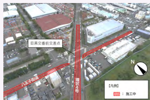
目黒交番前交差点付近 工事状況
