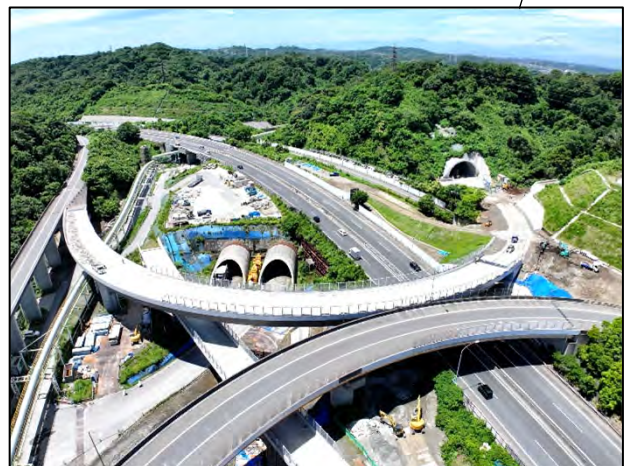
釜利谷JCT工事の状況
