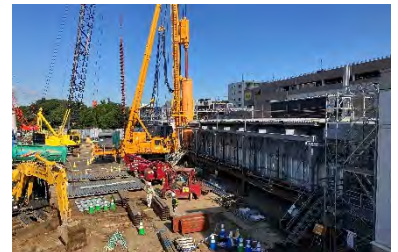
連続立体交差事業 (地下化する鶴ヶ峰駅の土留め工事)
