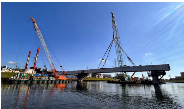
橋桁架設状況
