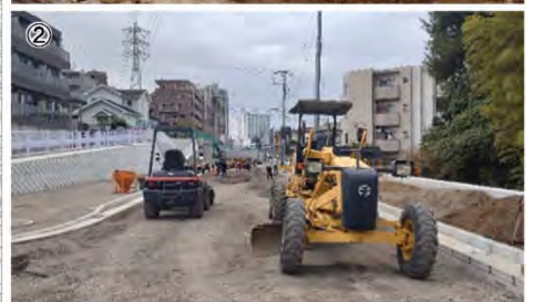
工事が進む鴨居上飯田線
