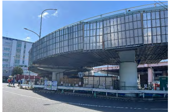
新子安橋(神奈川区): 桁、床板補修工事
