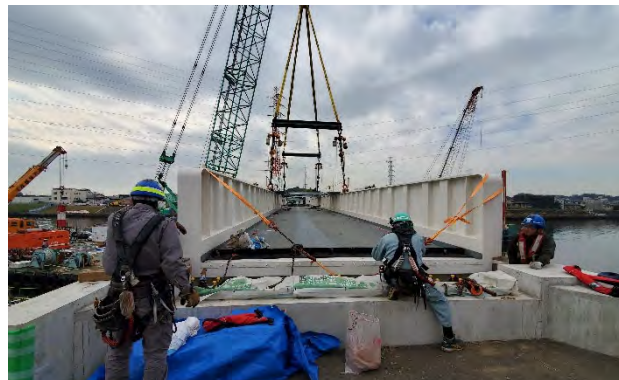
橋桁架設状況
