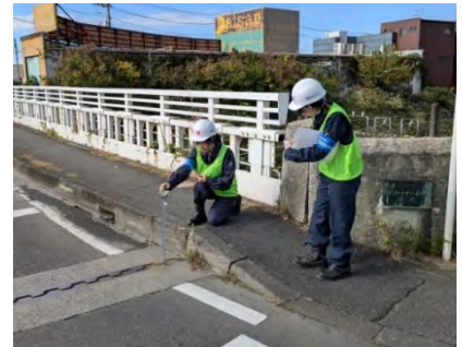
《関係団体による被害状況緊急調査の訓練》 （神奈川県測量設計業協会横浜支部） （横浜市地質調査業協会） （横浜市建設コンサルタント協会）
