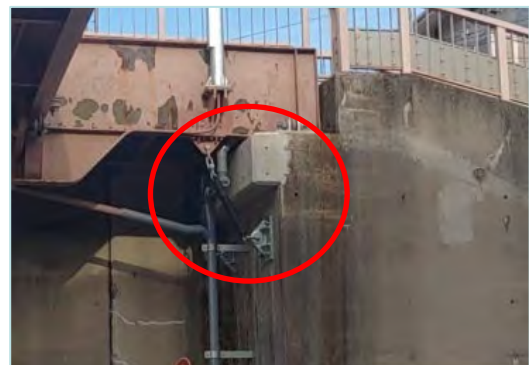
三ツ沢第三歩道橋(西区):橋台の縁端拡幅 6年2月完成
