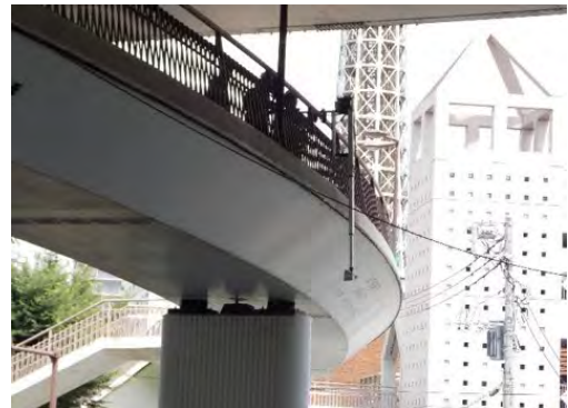
ボールカメラによる点検 フランス橋 (中区)
