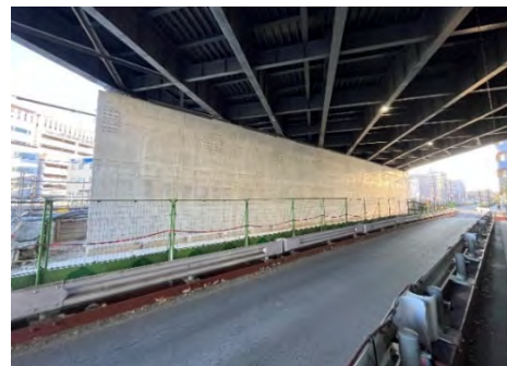
新横浜陸橋(港北区):橋脚の壁化の様況
