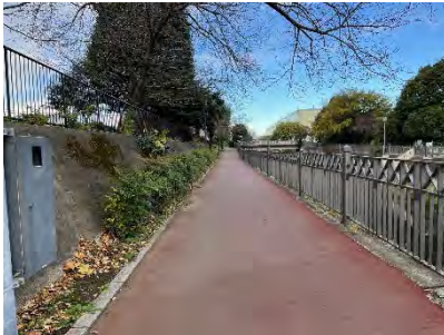
舗装の改修 (栄区:花や鳥、豊かな自然に出会ういち川ルート)
