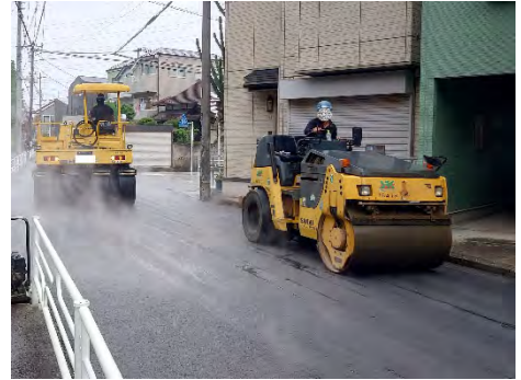
舗装修繕工事の状況(港北区)
