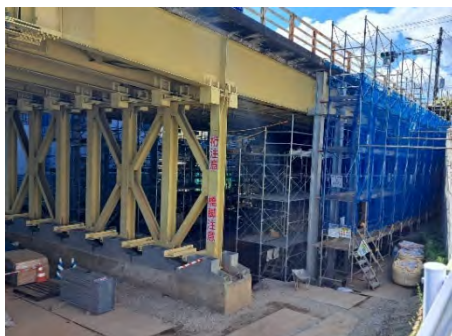
矢向第一陸橋(鶴見区):耐震化工事の様況
