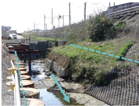
護岸改修 今井川: 保土ヶ谷区権太坂一丁目
