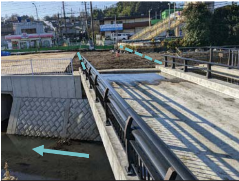
学校橋取付道路整備 (帷子川：旭区上川井町)
