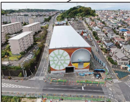
桂台トンネル工事 (栄区上郷町)
