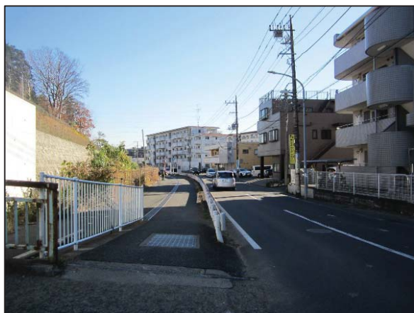
車道拡幅・歩道設置 市道上白根第99号線【白根六丁目地区】(旭区)
