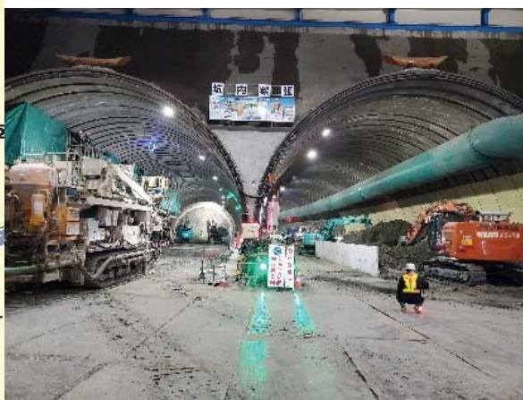
桂町トンネル工事
