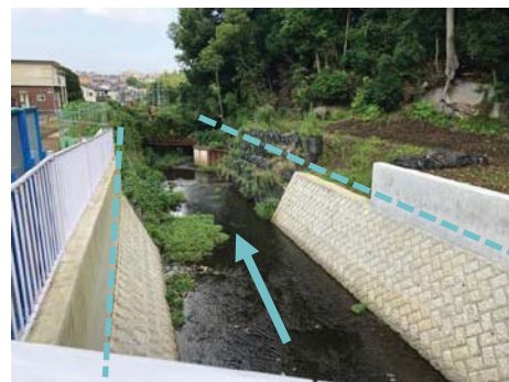
護岸改修 阿久和川: 泉区新橋町
