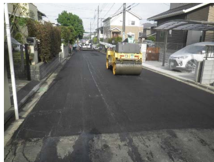
舗装修繕工事の状況(泉区)
