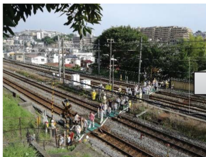
樹源寺踏切(保土ヶ谷区)現況
