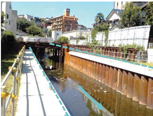
護岸改修 (今井川：保土ヶ谷区岩井町)
