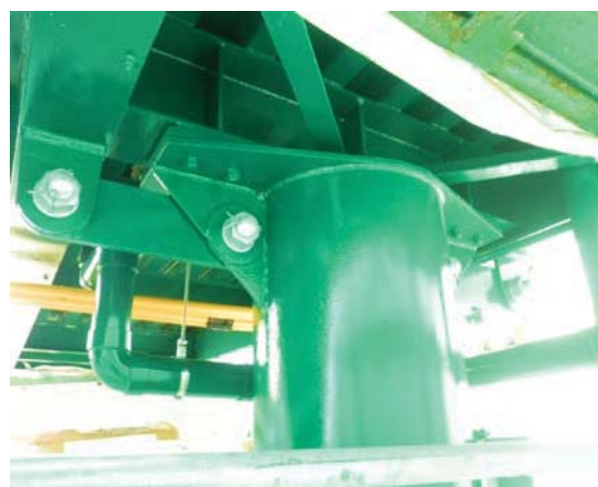
中里歩道橋(南区):落橋防止装置 令和4年1月完成
