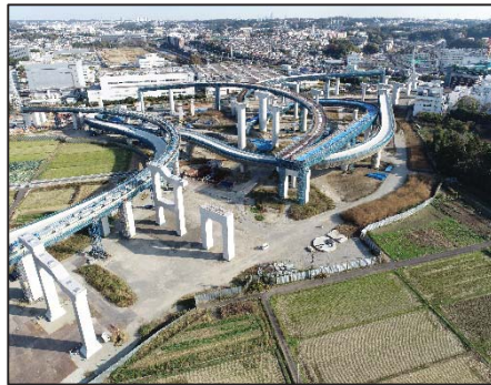
栄IC・JCT築造工事 (栄区田谷町)
