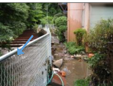
河川の溢水による床上浸水（橋際橋周辺）
