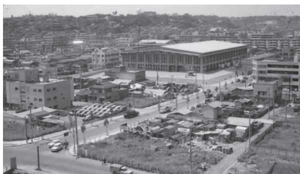
写真6 旧市役所側からみた文化体育館周辺 1964年5月 (横浜市史資料室所蔵、広報課写真資料・部分) 空地や材木置き場などがあり、柵や杭なども見える。根岸線開通当日なのでアドバルーン見える。
