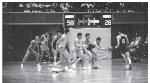
写真4 バスケットボール計時装置 1964年(横浜市史資料室所蔵、広報課写真資料) 左右に点数表示、中に残り時間表示、上に30秒ルール表示器がある。写真は、9月25日、予選初日のタイとインドネシアの試合。
