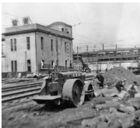
写真6 緑橋撤去工事 (中区) [10]
