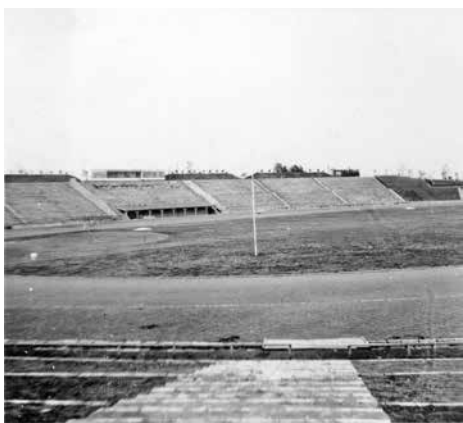
写真3 ミツ沢競技場（神奈川区）[7]
