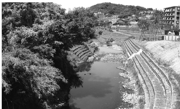
いたち川尾月橋下流完成
