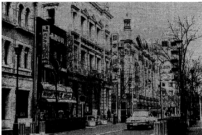
日本火災ビル改修前
