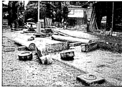
写真1 倒壊した鳥居
