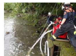
河川からの取水
