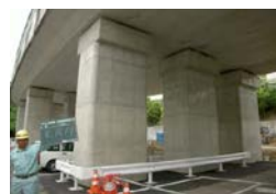
橋梁の耐震化 (谷津坂第一高架橋)
