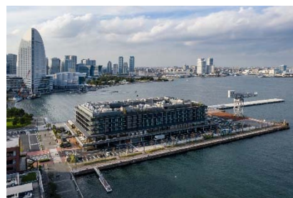
新港ふ頭客船ターミナル
