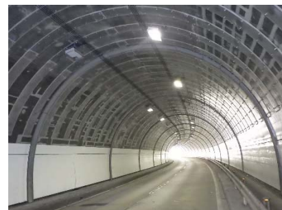
トンネル長寿命化工事後の状況
