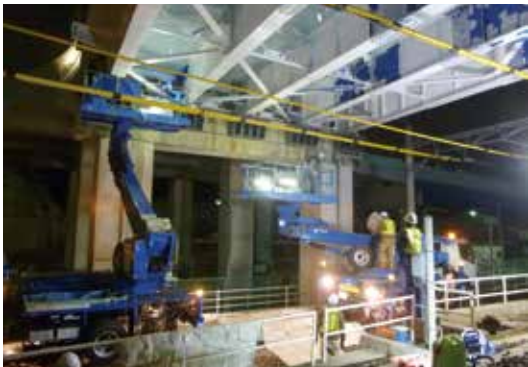
교량 보전 공사
