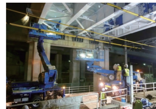
橋梁の保全工事
