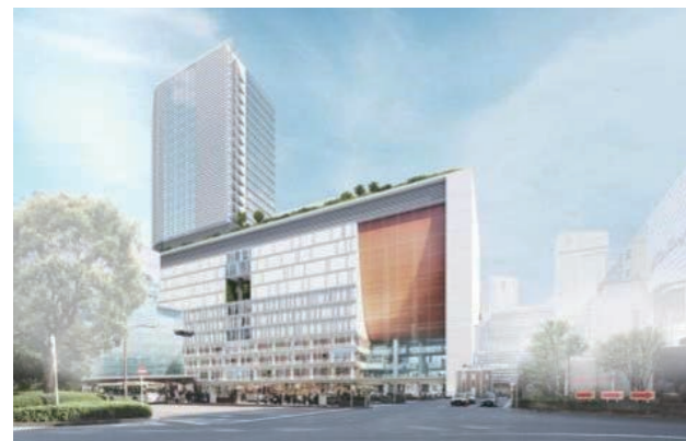
(仮称) 横浜駅西口開発ビル
