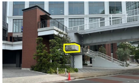
デッキ橋台(現地写真)
