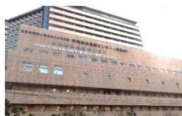
市民総合医療センター（南区浦舟町） ※手前が救急棟
