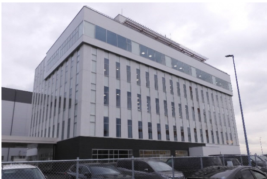
新管理棟(建設中)外観
