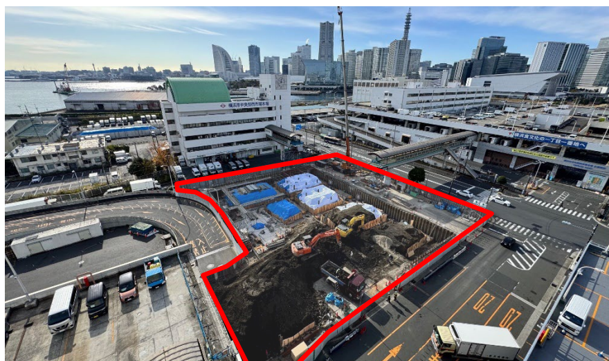
F1棟工事の様子(6年12月撮影)
