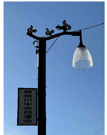
老朽化した灯具を交換した街路灯 (5年度/神奈川県中央商連会)
