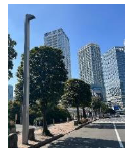
街路樹による良好な景観づくり
