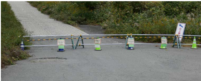
通行止め (単管バリケード)
