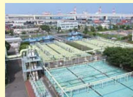
中部水再生センター
