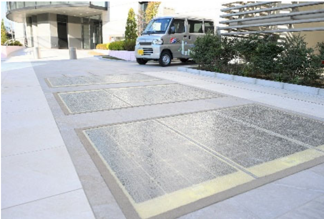
みなとみらい21熱供給センタープラント
