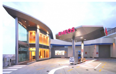
ENEOS 横浜綱島水素ステーション
