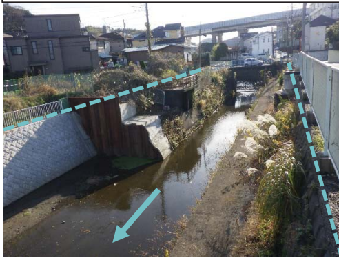
護岸改修、支障移設、用地補償 (準用日野川：港南区日野七丁目)
