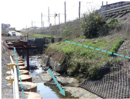
護岸改修 今井川: 保土ヶ谷区権太坂一丁目
