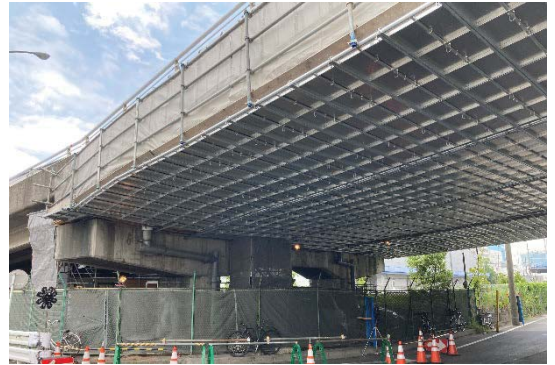
計画的な補修等: 新子安橋 (神奈川区) (コンクリート床版の補修、主桁の補強等)
