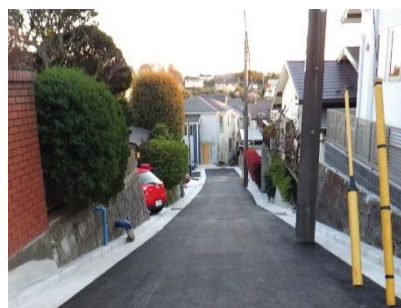
私道整備助成実施後(港北区)
