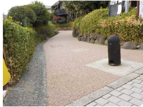
舗装の改修 (神奈川区:水と緑豊かな安らぎのルート)
