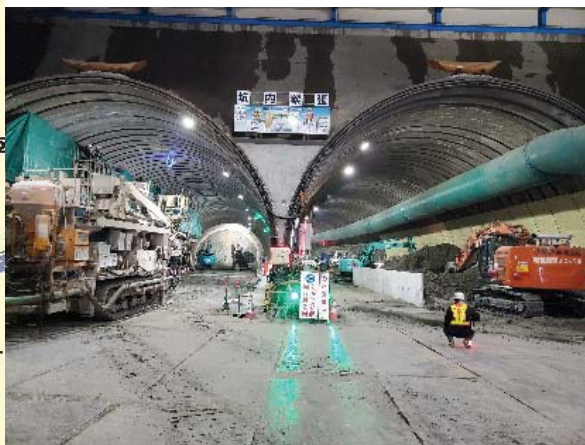
桂町トンネル工事
