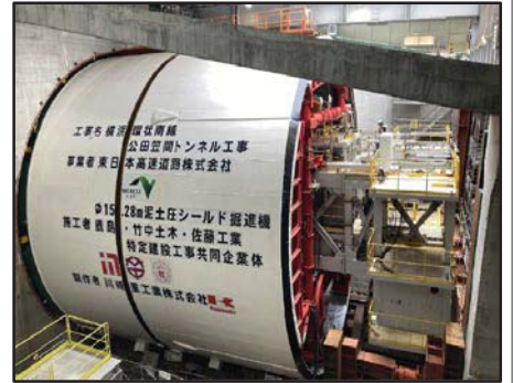
公田笠間トンネル工事 (栄区飯島町)
