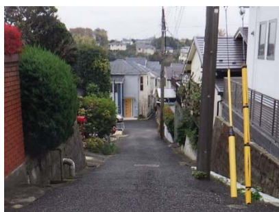
私道整備助成実施前(港北区)
