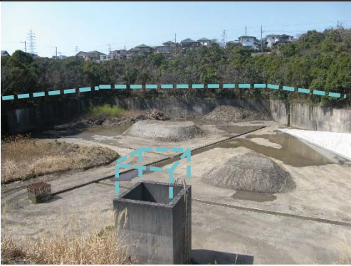
既設雨水調整池改良(貯留量の向上) (本郷台第一雨水調整池：栄区本郷台五丁目)
