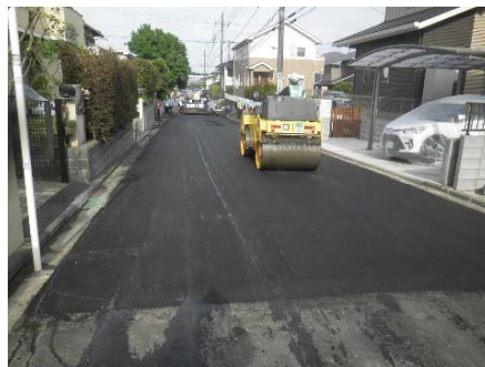
舗装修繕工事の状況(泉区)
