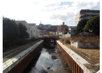
河川改修による護岸整備(今井川)
