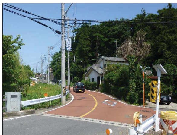
歩道設置 市道下瀬谷第438号線(瀬谷区)
