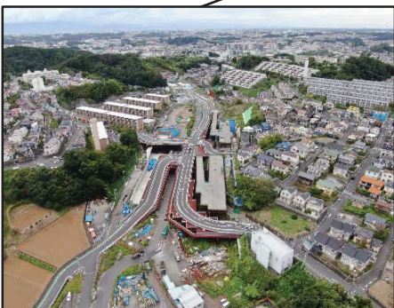
公田IC築造工事 (栄区公田町)
