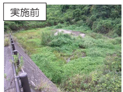
樹木伐採、除草、堆積土砂の掘削 (湘南桂台第一雨水調整池)
