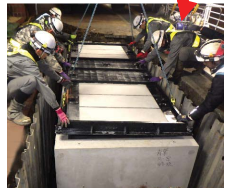
特殊部の設置状況
