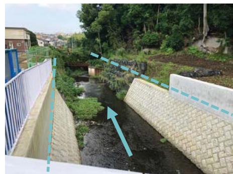
護岸改修 阿久和川: 泉区新橋町
