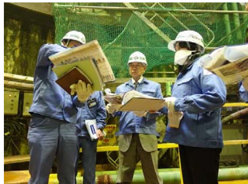
施工状況について説明を受ける監査委員 <平成28年11月18日>
